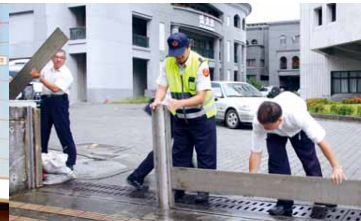
總務室警勤組同仁正在放置地下停車場入口的防水擋板。攝影 / 彭薇勻
